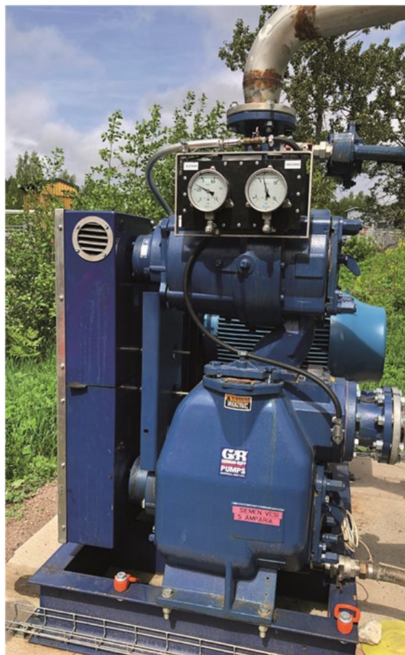
Kuvassa Gorman Rupp VS3A60 itseimevä keskipakopumppu
